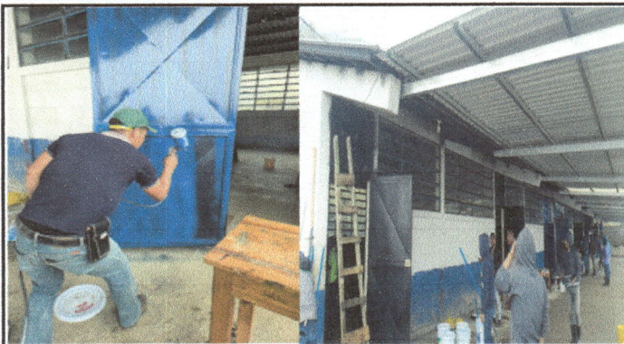
Foto 2: Se observa el mantenimiento de puertas y ventanas en las aulas y dirección.
