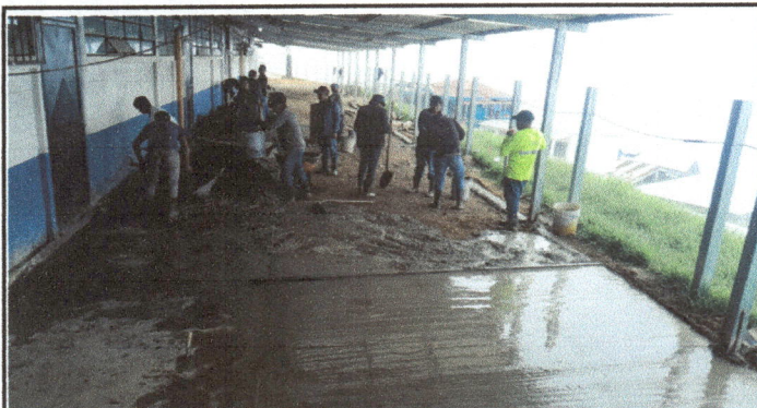
Foto 3: Se observa la rehabilitación de torta de concreto en el pasillo del modulo 1.
