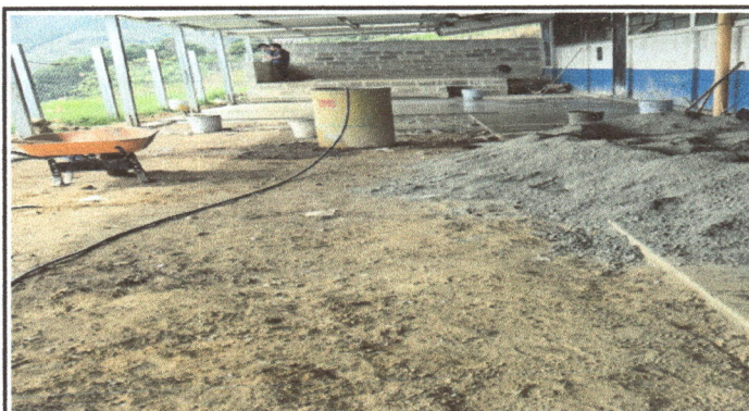
Foto 4: Se observa la rehabilitación de piso de torta de concreto en el pasillo de las aulas.
