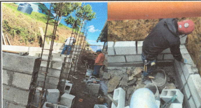
Foto1: Se observa fotografía de la rehabilitación de servicios de baños y del sistema de fosa septima lavable.
